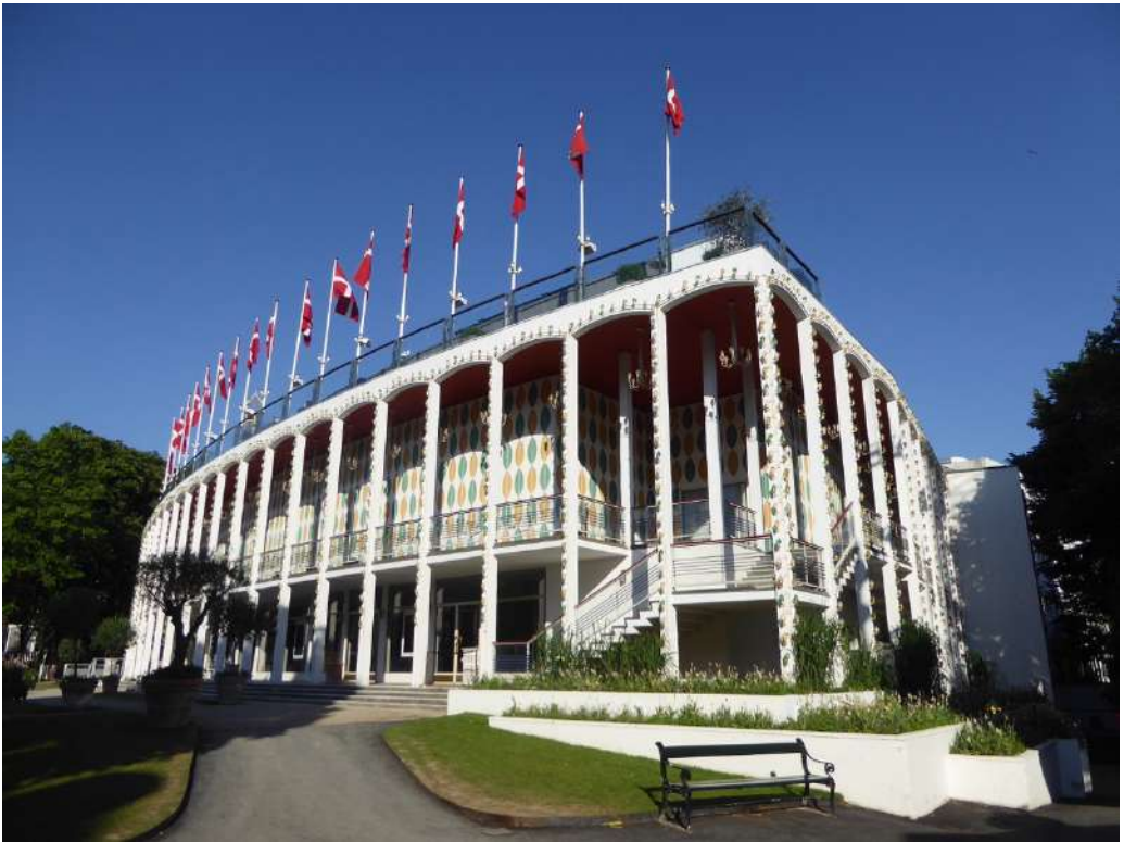
Den nye koncertsal, tegnet af arkitekterne Frits Schlegel og Hans Hansen, bliver først en realitet 12 år efter branden i 1944. Foto: Leif Jørgensen.
